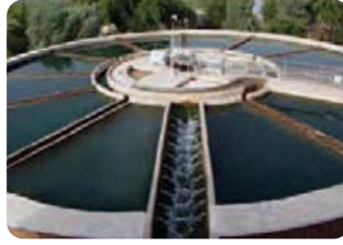
آب در تصفیه‌خانه
